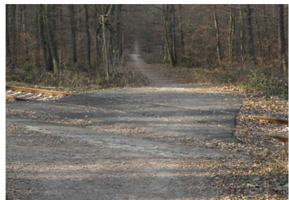
Abbildung 4: Der Bahnübergang „Nördlich Wenzel-Jaksch-Straße“ (km 8,5).
