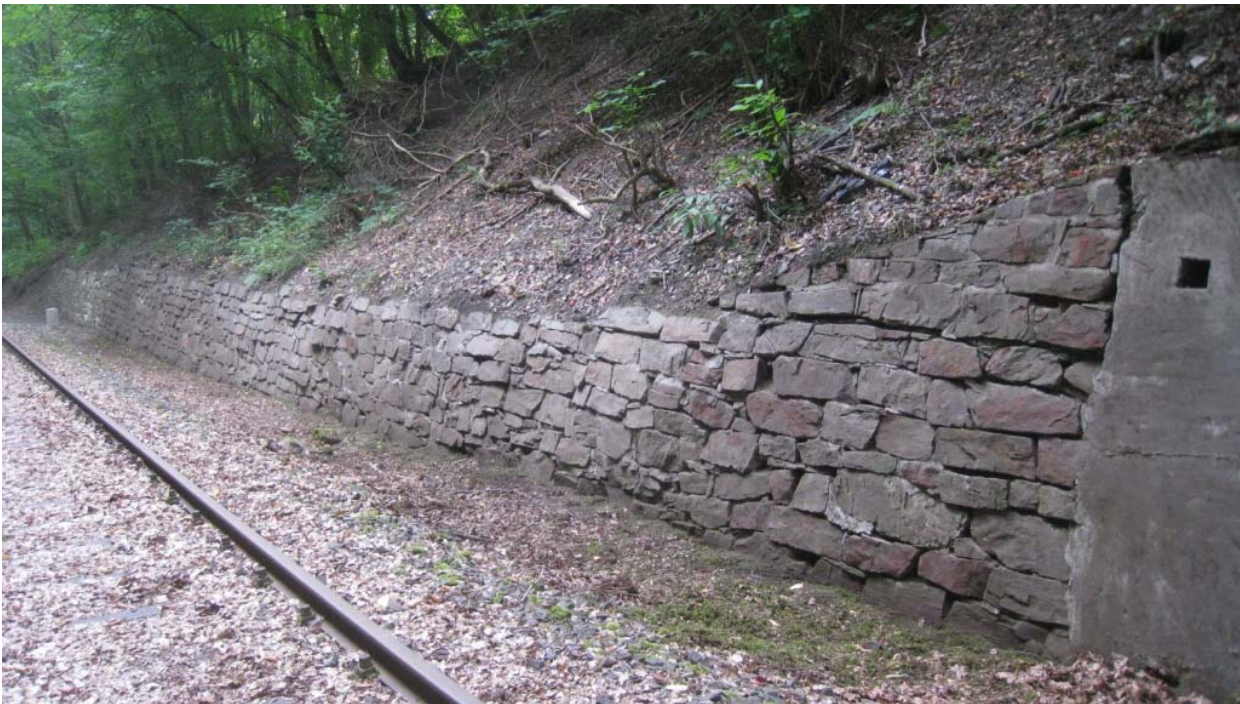
Abbildung 7: Die Stützmauer bei km 10,1 nach der Instandsetzung durch die NTB
