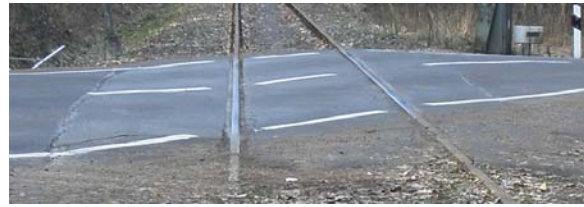
Abbildung 5: Der Bahnübergang Wenzel-Jaksch-Straße (km 8,3) Rechts und links des BÜ ist deutlich der Wechsel zwischen altem und neuem Straßenbelag zu erkennen.
